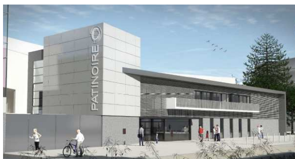
façade après les travaux
