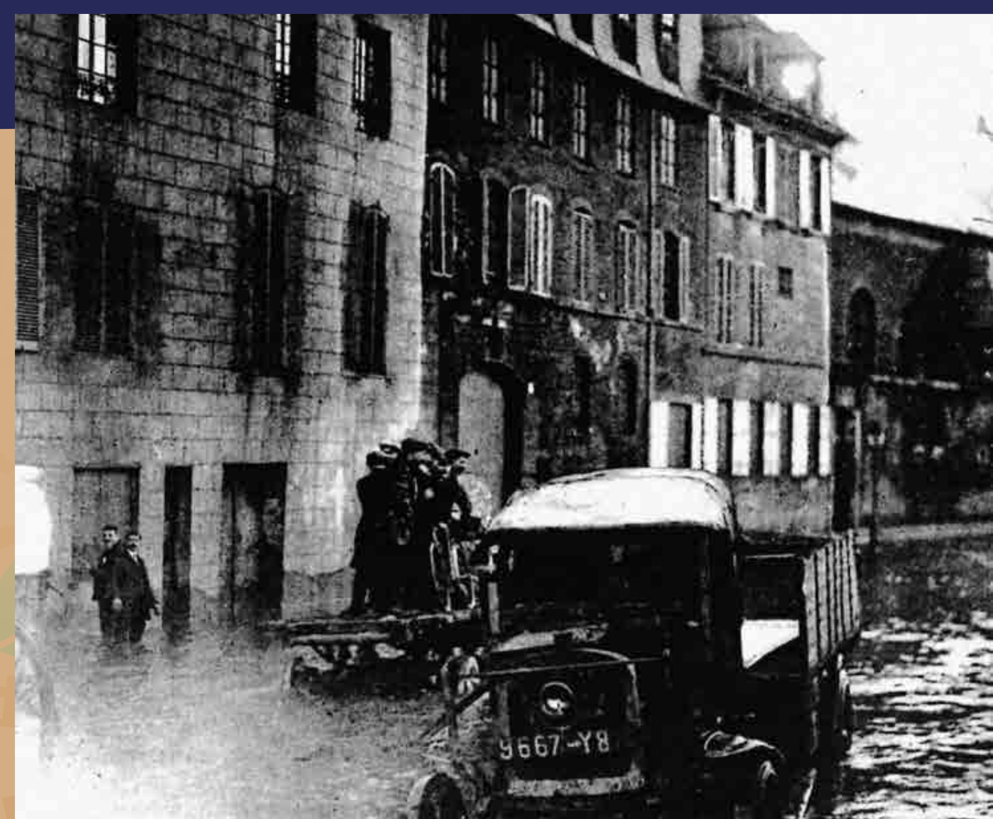
Effondrement de la chaussée au coin de la rue des Carnes.
