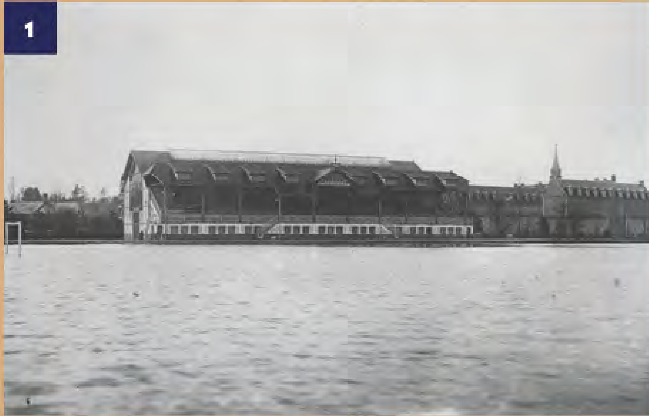
1 Stade Héлитas - Reproduction d'un carnet de cartes postales édité après la crue de l'Orne - Photographie répertoriée par la direction de l'eau et de l'assainissement de Caen en 2007.
