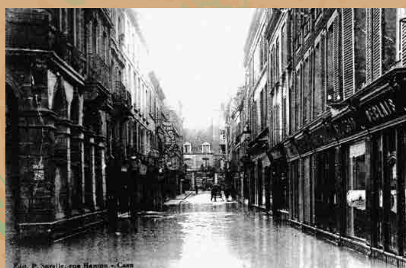
Toutes les rues du quartier Saint-Jean sont ravинées, les pavés déchaussés.
