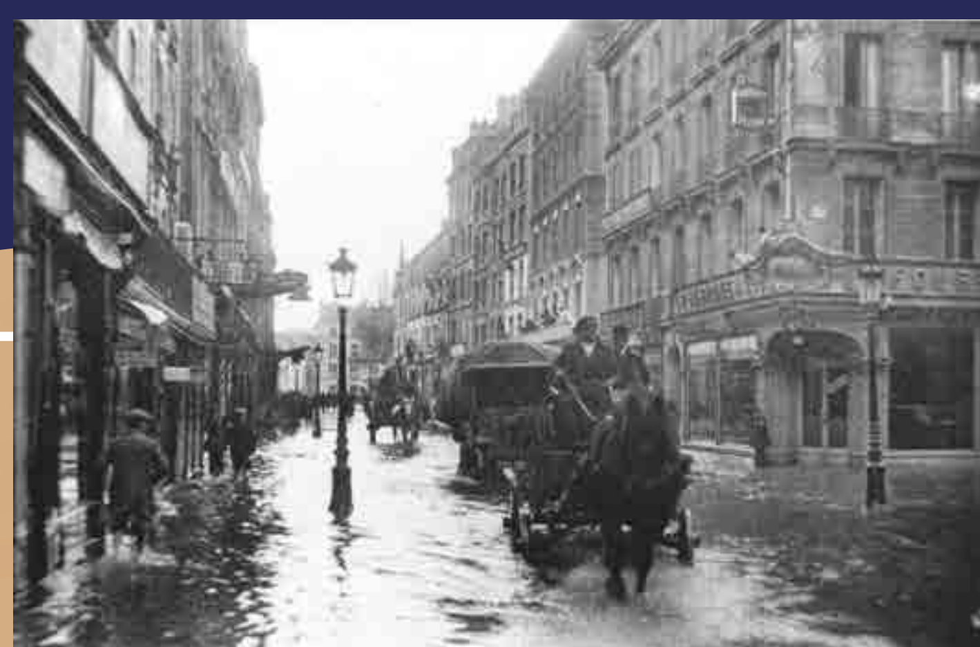
L'Odon sort de son lit : la rue de Strasbourg, et la rue Saint-Pierre sont inondées.
