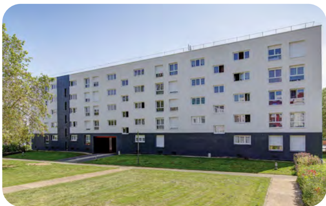
Rénovation BBC, quartier du Grand Parc à Hérouville Saint-Clair (crédit photo Calvados Habitat)
