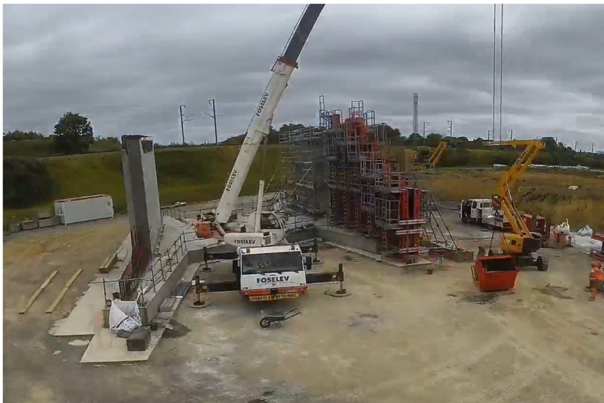
Construction du pont-rail
