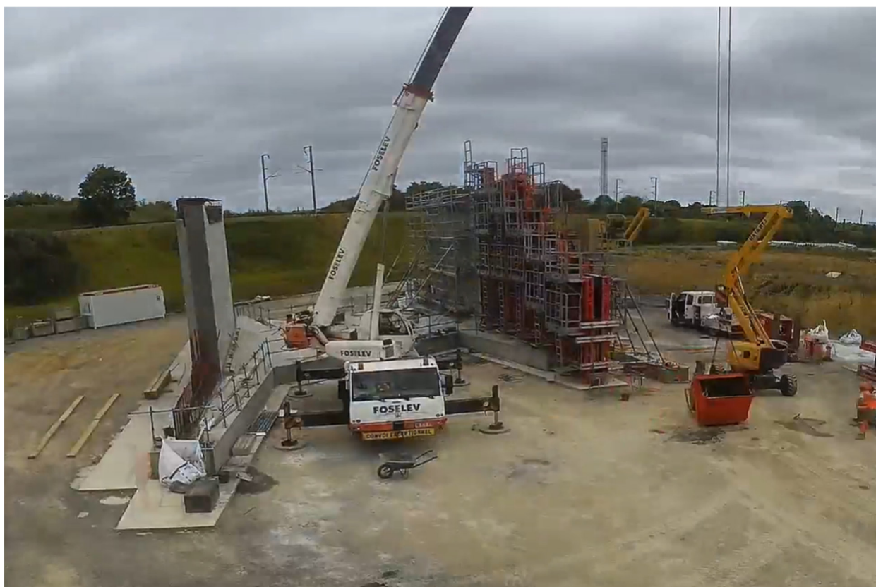
Construction du pont-rail
