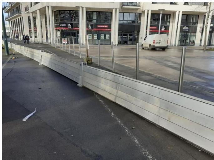
*Système de batardeau par lames en aluminium*
