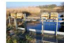
Ouvrage à Périers-en-Auge—NCPA 2025 ©
