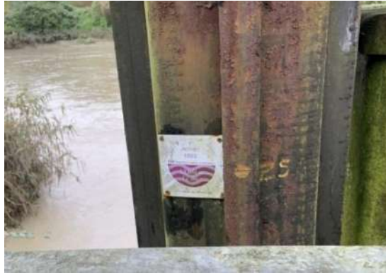
Figure 90 : Repère de crue à Mondeville, vanne de sortie du Biez – 10/2024
