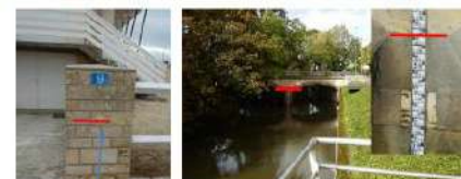
Exemples de laises de submersion marine ou de crues à Ver-sur-Mer et Argentan
