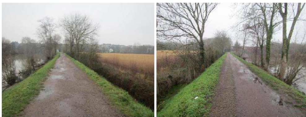
Vues du sous-tronçon FLE_02 de la digue de l'île Enchantée – ISL, 12/2023
