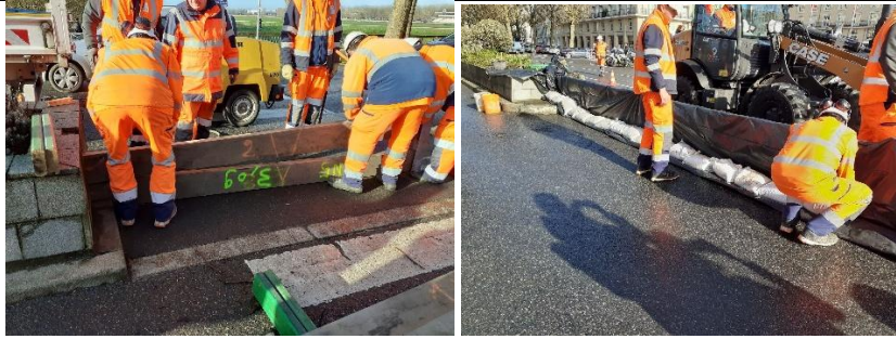
Exercice de gestion de crise 03/06/2024 – Pose des batardeaux en bois et mise en place d'un film polyane lesté - SMLCI
