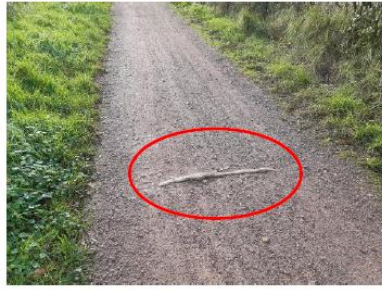
Figure 3-9 : Développement racinaire dans le corps de digue
