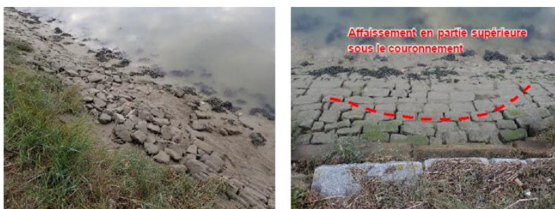
Figure 3-8 : Perré du talus amont du tronçon T2
