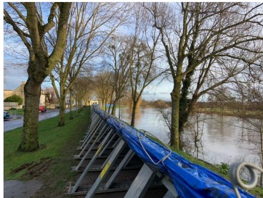
Aquabarrières posées en janvier 2025 sur la petite digue de Louvigny – Caen la Mer
