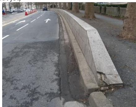
Arbres de haut jet à proximité de la murette béton
