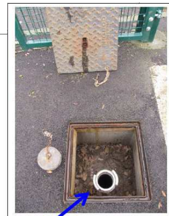
Regard contenant le tube vertical d'hydrocurage
