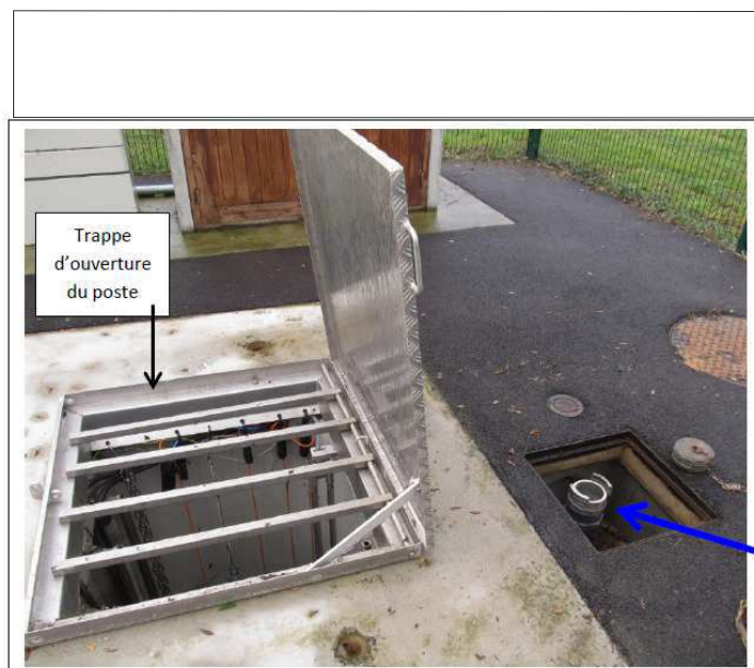
Regard contenant le tube vertical d'hydrocurage
